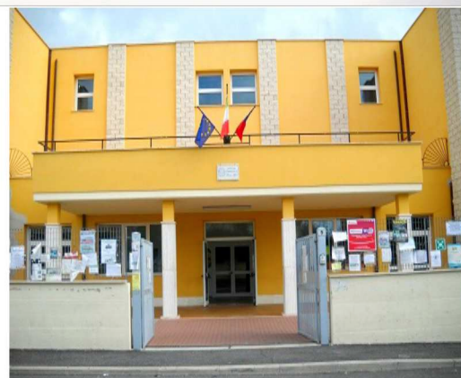
L'Istituto Comprensivo Ilaria Alpi di Ladi- spoli
