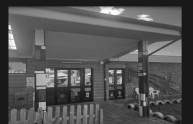
Ingresso viale Virginia
